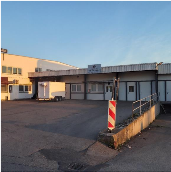
Abb. 6: Insbesondere die Vordächer an den bestehenden Gebäuden werden von mehreren Paaren des Haussperlings ( Passer domesticus ) zur Brut genutzt.
